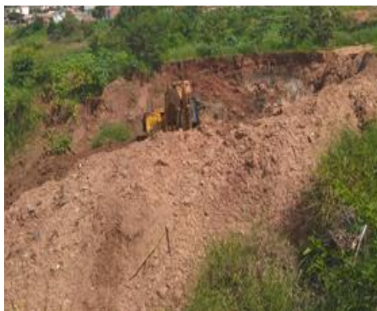
Figura 5: Terraplanagem da voçoroca.
