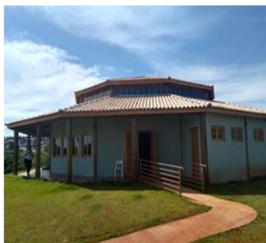
Figura 3: Sede do Centro Ambiental.
