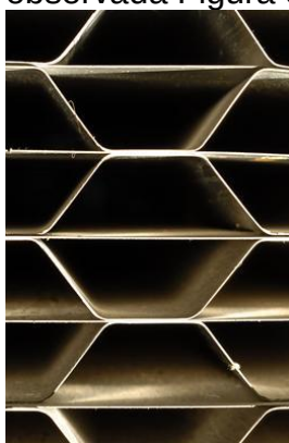
Figura 3: Apresentação em detalhe do formato de colmeia da câmara de suavização de fluxo. Fonte: (ARA, 2012)
